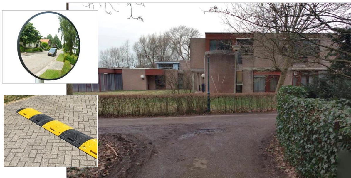
Figuur 5.5: Kruispunt gezien vanaf het weggetje van/naar de woningen, het zicht op verkeer van rechts is slecht door de hoge groene haag (bron: Cyclomedia)
